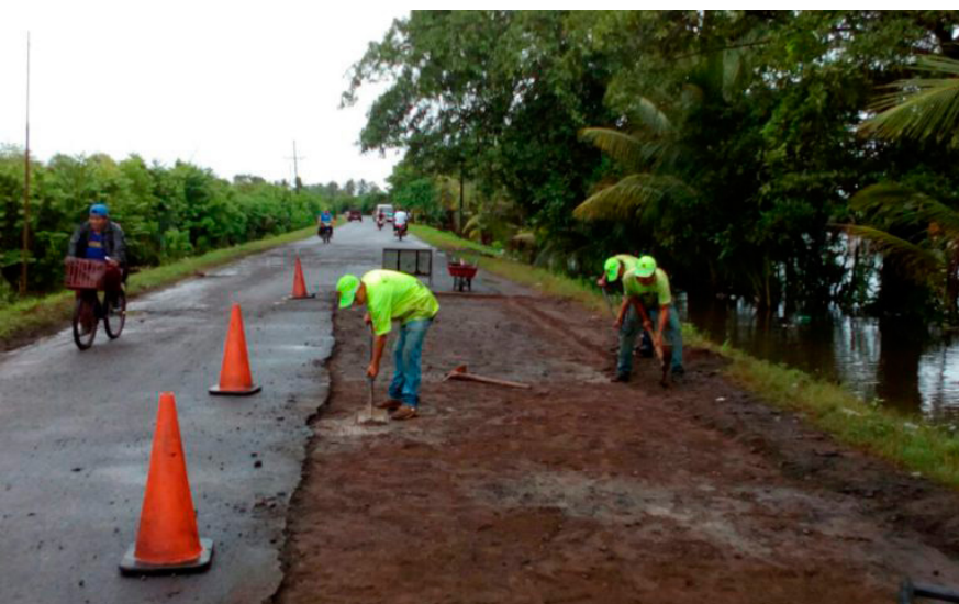
Foto: Mantenimiento de carretera
