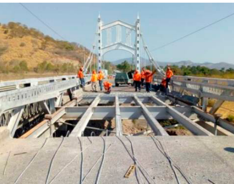
Foto: Construcción de carreteras
