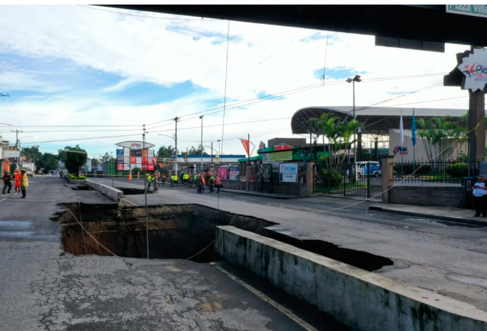
Foto: Socavón de Villa Nueva
